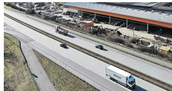
Auf der A13 sind Arbeiten notwendig.
